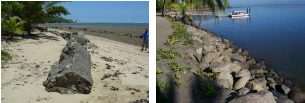
Ata 36: E mana'o se galuega tele e su'esu'e ma fua lelei ai le fa'ata'atiaga o taligalu ina ia mautinoa e mālosi. O taligalu o fua mālosi ma e tau fo'i o filifiliga 'ma'ale'ale'. E puipuia meatōtino i tua o le taligalu ae e ātili 'āia ai le oneone 'olo'o iai i le matāfaga
