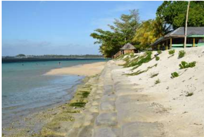
Ata 38: Fa'ata'ita'iga o taga oneone ua tu'u i luga o le matāfaga ma totō ai lā'au
