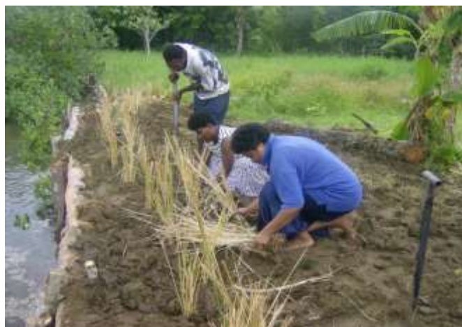
Ata 23: 'olo'o fa'aaogā e le nu'u meafaitino mai le si'osi'omaga e tāofi ai le auvai Ata 24: Totōina o le vao Vetiver ma le fa'atumuga o tua o le vāega puipui
